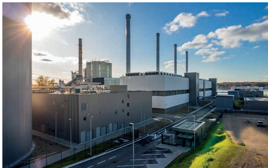
Das Herzstück des Küstenkraftwerks besteht aus 20 Jenbacher J920 Flextra Gasmotoren und versorgt die deutsche Stadt Kiel mit 190 Megawatt Strom. „Bildrechte: Stadtwerke Kiel“
