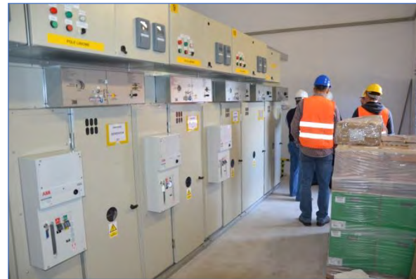
Uruchomienie stacji SN 15 kV
