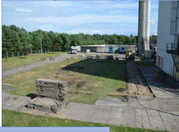
Miejsce pod planowany budynek kogeneracji
